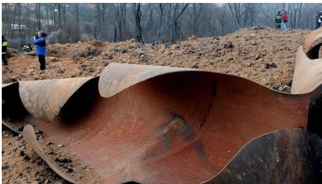
Obr. 3 – Poškodenie plynového potrubia DN 700 Bratstvo (katastrálne územie Slanec pri Košiciach r. 2008)
