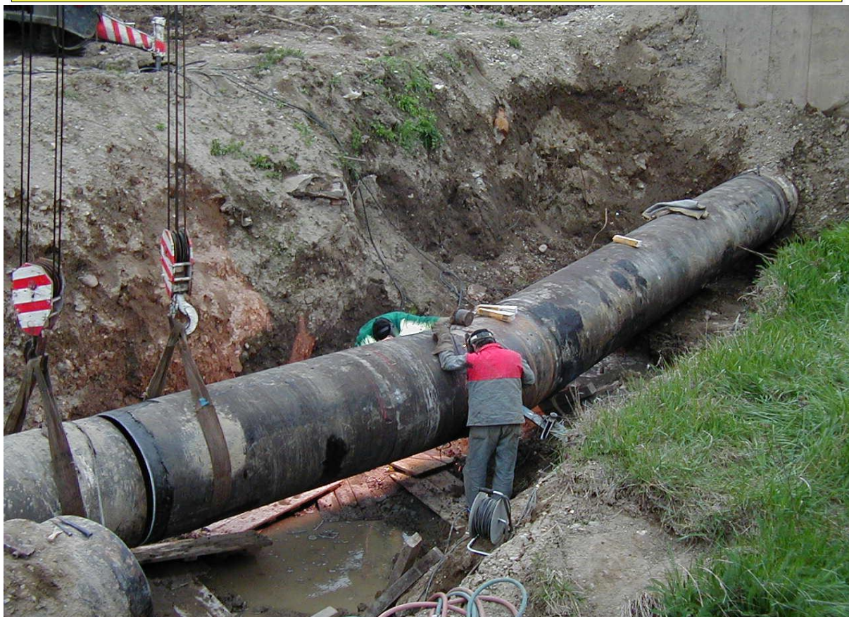
Obr. 1 – Výstavba plynovodu DN 700
