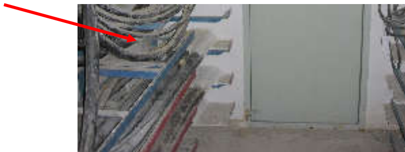
Obrázok 6 Azbestové dosky na káblových lávkach
