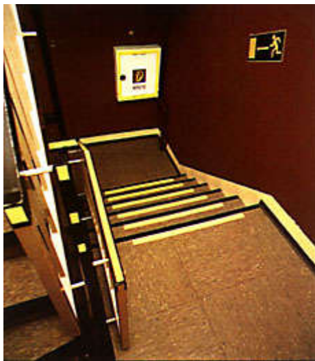
Fotoluminiscenčné bezpečnostné označenie schodiska a požiarneho hydrantu.
