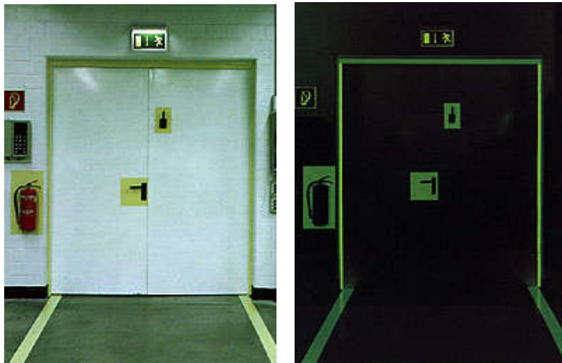
Fotoluminiscenčné bezpečnostné označenie dverí únikového východu a prenosného hasiaceho prístroja.
