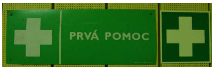
Obr. 13 Bezpečnostná značka „Prvá pomoc“ vyrobená z PVC a fotoluminiscenčné bezpečnostné značenie „Miesta prvej pomoci“ za svetla.
