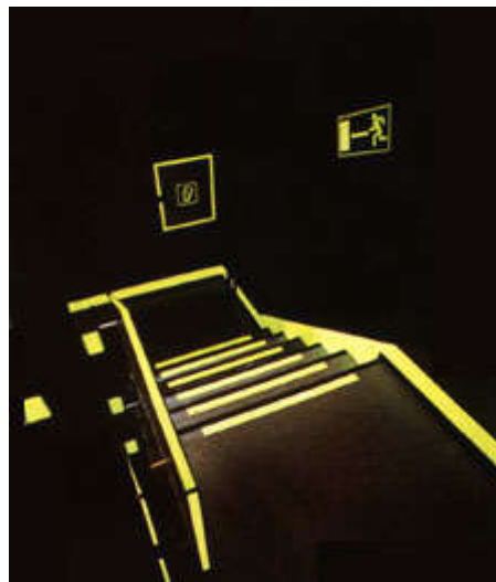
Fotoluminiscenčné bezpečnostné označenie schodiska a požiarneho hydrantu.
