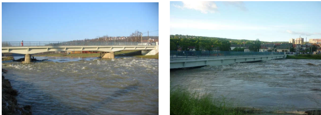
Obr. 4. Most na rieke Hornád pri obci Ťahanovce: vľavo normálny stav rieky, vpravo povodňový stav rieky v roku 2010.
