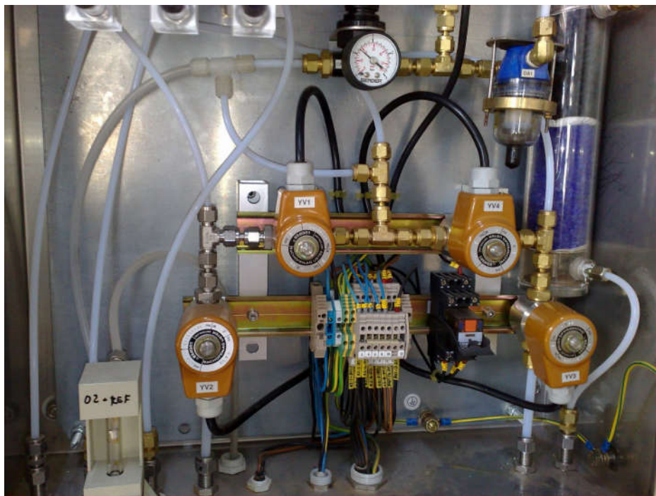
Obr.7 Skrinka AZU s adsorbčným filtrom technologického rozvodového vzduchu
