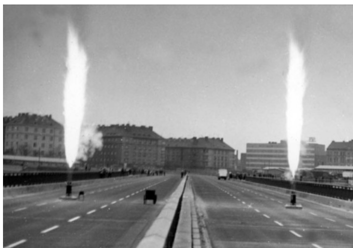
Obr. 3 - Dynamická zkouška Nuselského mostu [9]
