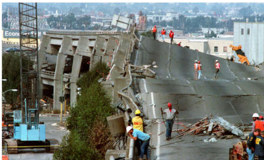
Obr. 2 - Most Cypress Street Viaduct po zemětřesení v Kalifornii v roce 1989 [8]
