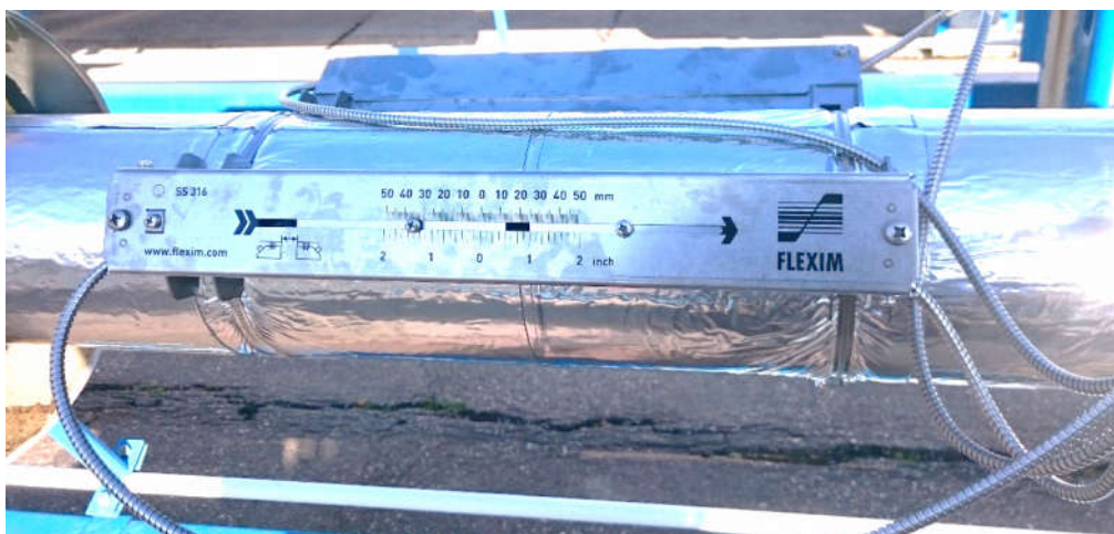
Abb 5 Installation von Ultraschallsensoren an der Rohrleitung.
