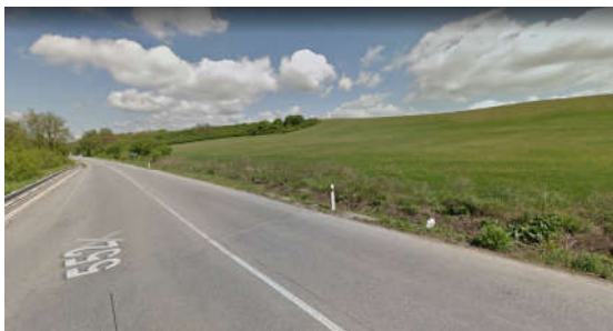
Obr. 2. Pohľad na záujmové územie a dokumentovanú cestnú komunikáciu.
