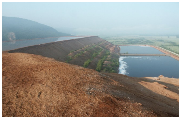
Obrázok 2 Pôvodný stav na odkalisku – plné alkalických vôd
