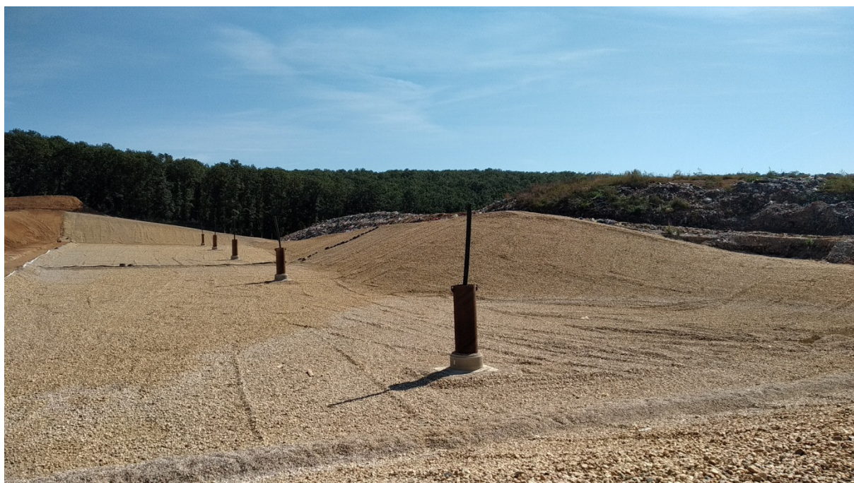
Obrázok 1: Založenie pasívnych odplynovacích studní na dne kazety.
