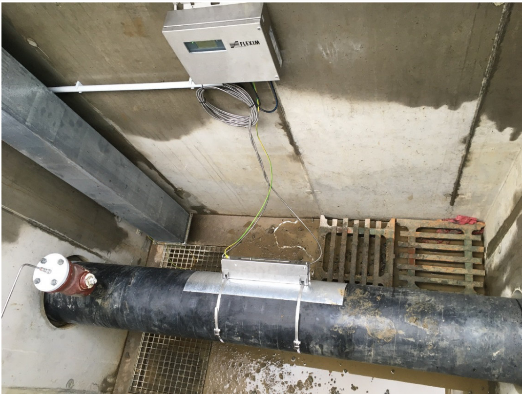
Obr. 2 Osadenie meracej jednotky Flexim G721 a pripojenie ultrazvukových senzorov.
