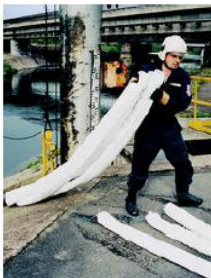
Obr. 3 - Príprava sorpčných hadov [3]
